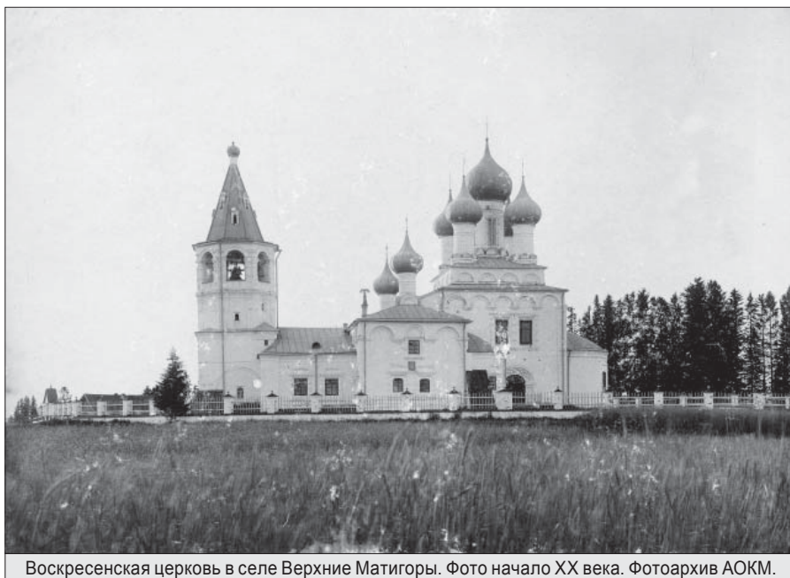
Воскресенская церковь в селе Верхние Матигоры. Фото начало XX века. Фотоархив АОКМ.
